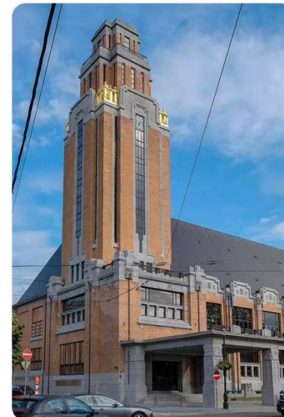
Rénovation d'un hôtel de ville (Forest 2023)
