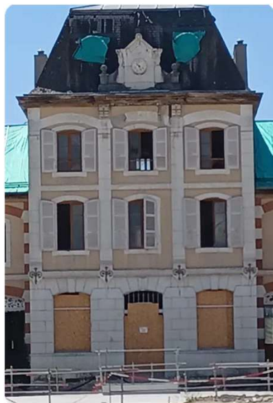
Rénovation d'un bâtiment patrimonial (Annecy 2024)
