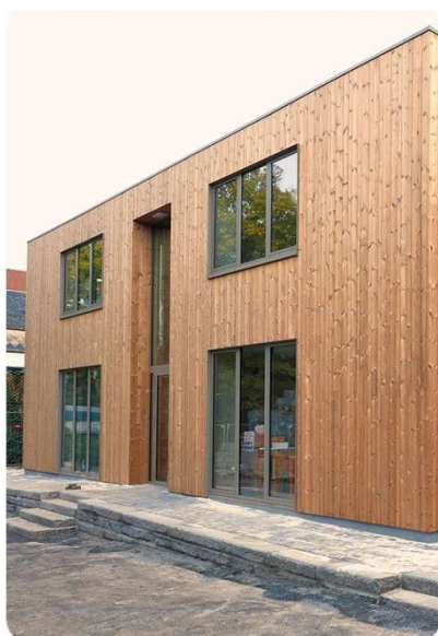
Construction d'une annexe à une école (Binche 2017)
